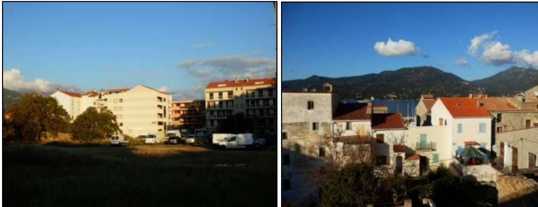
Figure 68 – Les extensions au Sud-Ouest parallèle à l’avenue Napoléon III et au Sud-Est, parallèle à la rue du 9 septembre. Source : MAP.
