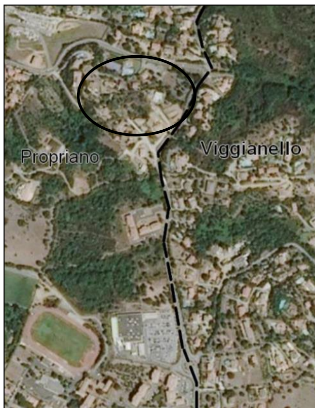
Figure 77 - Vue aérienne Limites Nord-Est Propriano-Viggianello. Source : SPOT 6 2016
