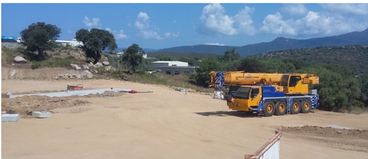
Figure 140 - Les travaux en cours de réalisation sur le secteur Est
