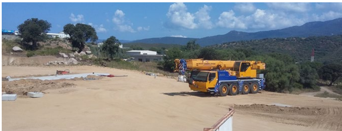
Figure 79 - Les travaux en cours d'achèvement sur la zone d'activités. Source : MAP.
