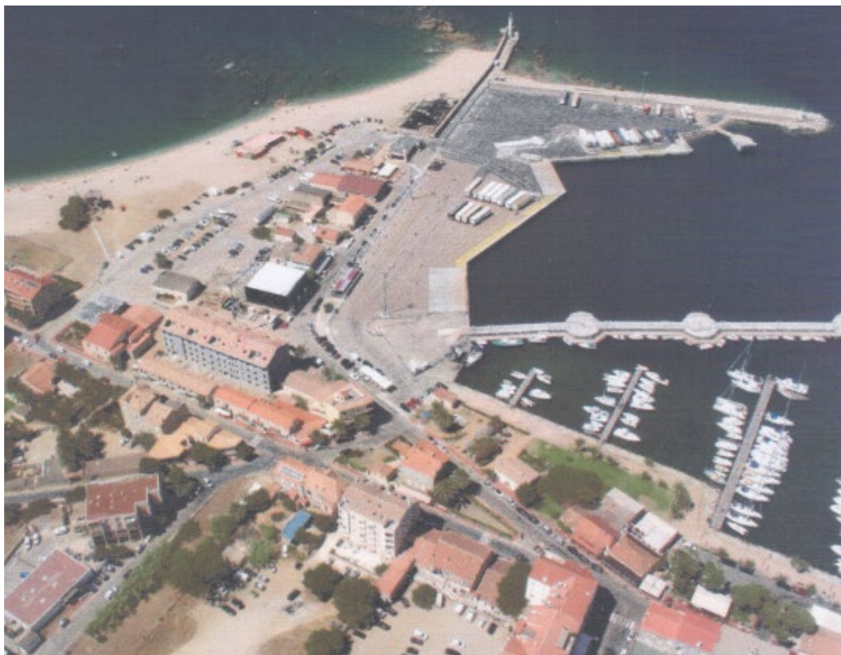
Figure 37 – Vue aérienne du port de Propriano. Source : Google.
