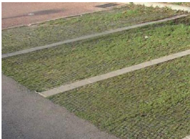
Places de parking enherbées non étanches (Source Grand Lyon)
