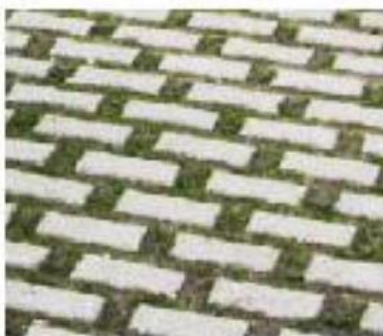
Pavage en béton avec ouvertures de drainage
